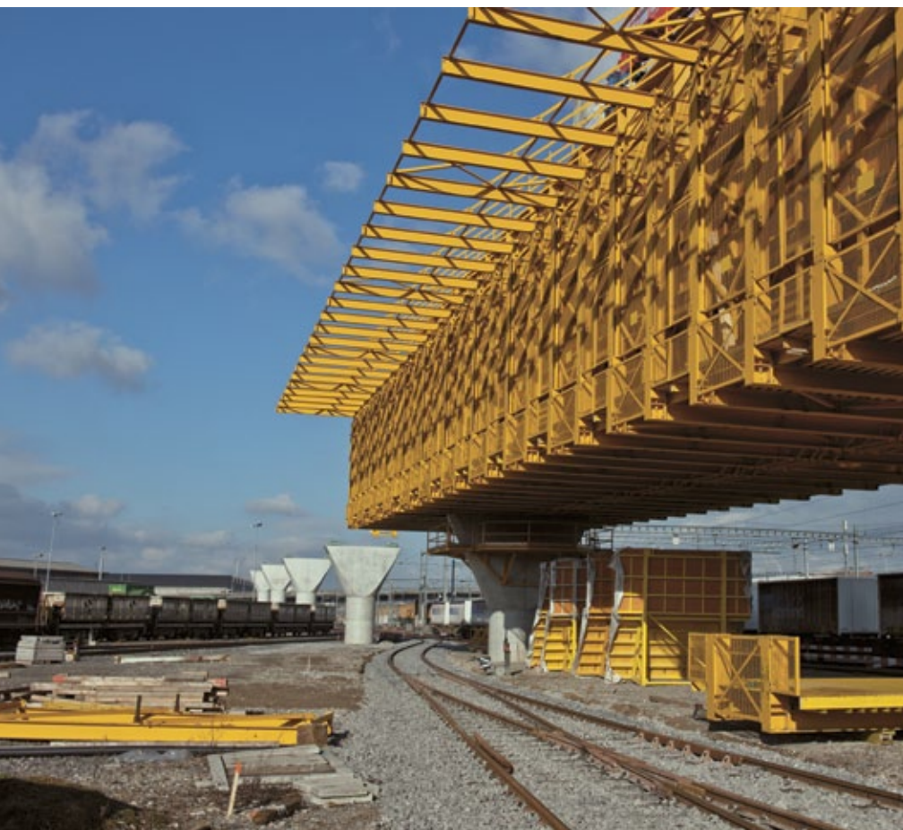
Ligne diamétrale de Zurich: la réalisation du pont du Letzigraben se déroule comme prévu.
