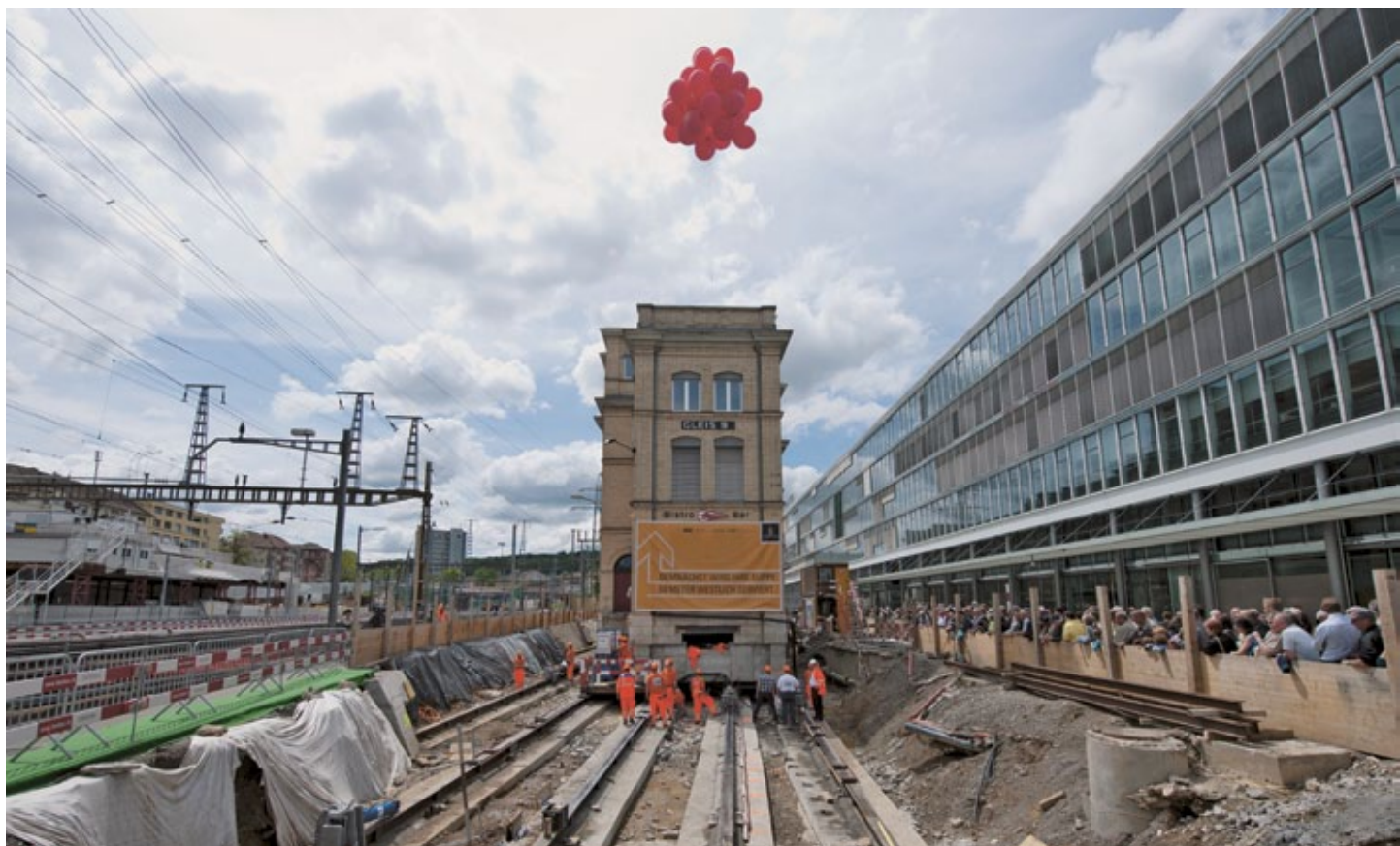
Le bâtiment en briques de l'ancienne «Maschinenfabrik-Oerlikon» a été déplacé de 60 m.
